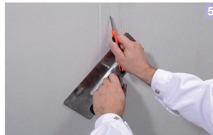
Doppelnahtschnitt mit dem Cuttermesser setzen und abgetrennte Vliesstreifen entfernen.
