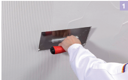
Den decorur Leichtspachtel auf die Fläche auftragen und mit der Zahnkelle (Zahnung von 4 x 6 x 4 mm) durchkämmen. Nur soviel Material aufbringen, wie das Spachtelvlies breit ist.
