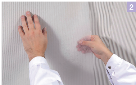
Das Spachtelvlies in die noch nasse Spachtelmasse einlegen.
