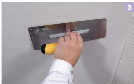
Die Zahnkellenstruktur unterhalb des Vlieses mit einer Glätte-Kelle verpressen, bis die Spachtelmasse leicht das Vlies durchdringt. Dabei bis ca. 5 mm an den Nahtbereich arbeiten.
