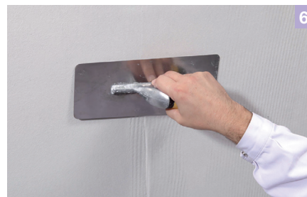
Nahtbereich andrücken und anschließend auch hier die Zahnung verpressen, bis die Spachtelmasse ganz leicht das Vlies durchdringt. Wiederholen Sie den Vorgang bis zur vollflächigen Fertigstellung.
